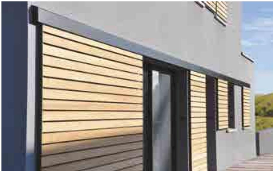
L'ensemble des rails hauts peuvent être configurés en rail filant entre les baies d'une même façade sur demande.
